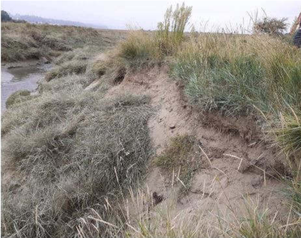
Glissements de terrain sur une digue en terre victime de l'érosion. Elle pourrait alors s'effondrer complètement lors de la prochaine crue du cours d'eau.
