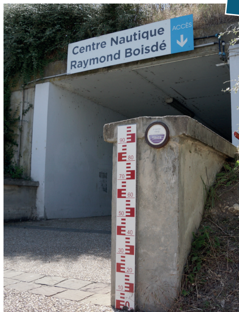
Passage souterrain, Centre Nautique (90cm)
