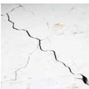
Le phénomène de retrait-gonflement des argiles se manifeste en fonction de la teneur en eau des sols. Ceux-ci sont alors soumis à des variations de volume, pouvant provoquer des fissurations en façade, un décollement des perrons et des terrasses, une distorsion des portes et des fenêtres, une dislocation des dallages et des cloisons, une rupture des canalisations enterrées...
