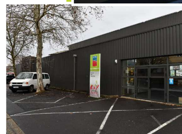
Gymnase des Camisières ©Christian GENOT
