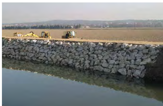
Renforcement de digue du canal du Vigueirat à la suite des inondations de l'automne 2003
